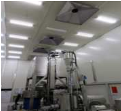
Hình 3.14. Hệ thống xử lý bụi công suất 20.000 m 3 /giờ (giai đoạn 1)
